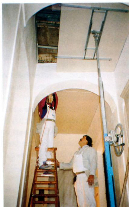
Realizzazione delle opere in gesso rivestito all'interno del blocco scale di Palazzo Firmian: sollevamento di una lastra per controsoffitto.
