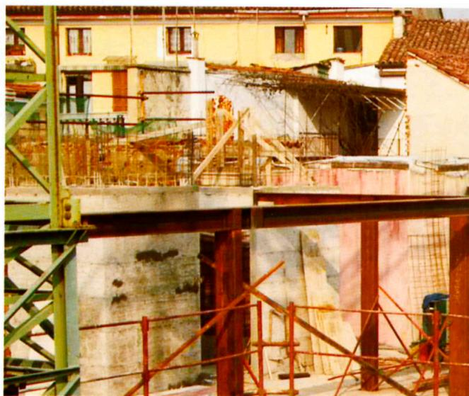
*Realizzazione delle strutture portanti fuori terra in acciaio e degli impalcati in profili pressopiegati di acciaio zincato.*
