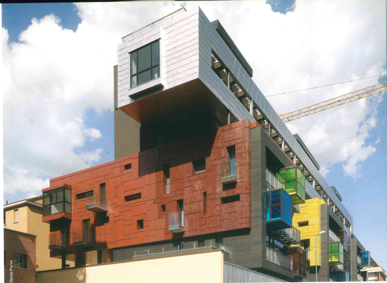
Vista nord ovest dell'intervento North West view of the project
