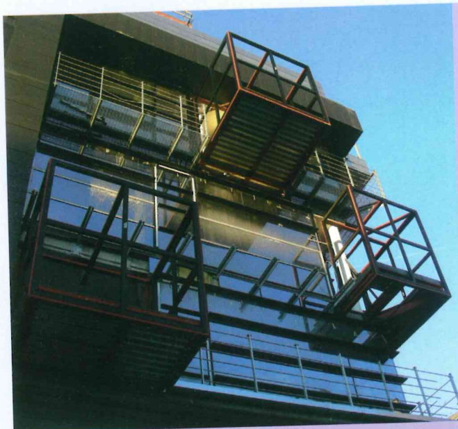
I prospetti sono caratterizzati dalla presenza di alcuni bow window colorati realizzati con struttura metallica a sbalzo dai cordoli perimetrali e tamponamenti vetriati.
